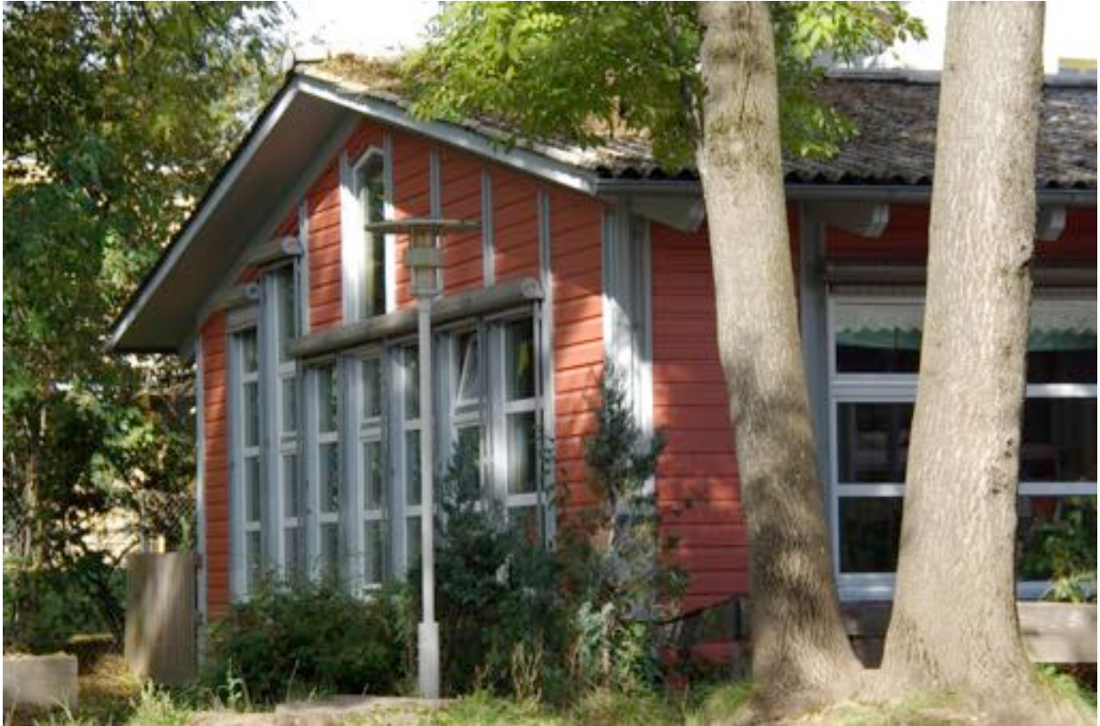
Die beiden Pavillons oberhalb des Pausenhofs werden 2015 abgerissen.
