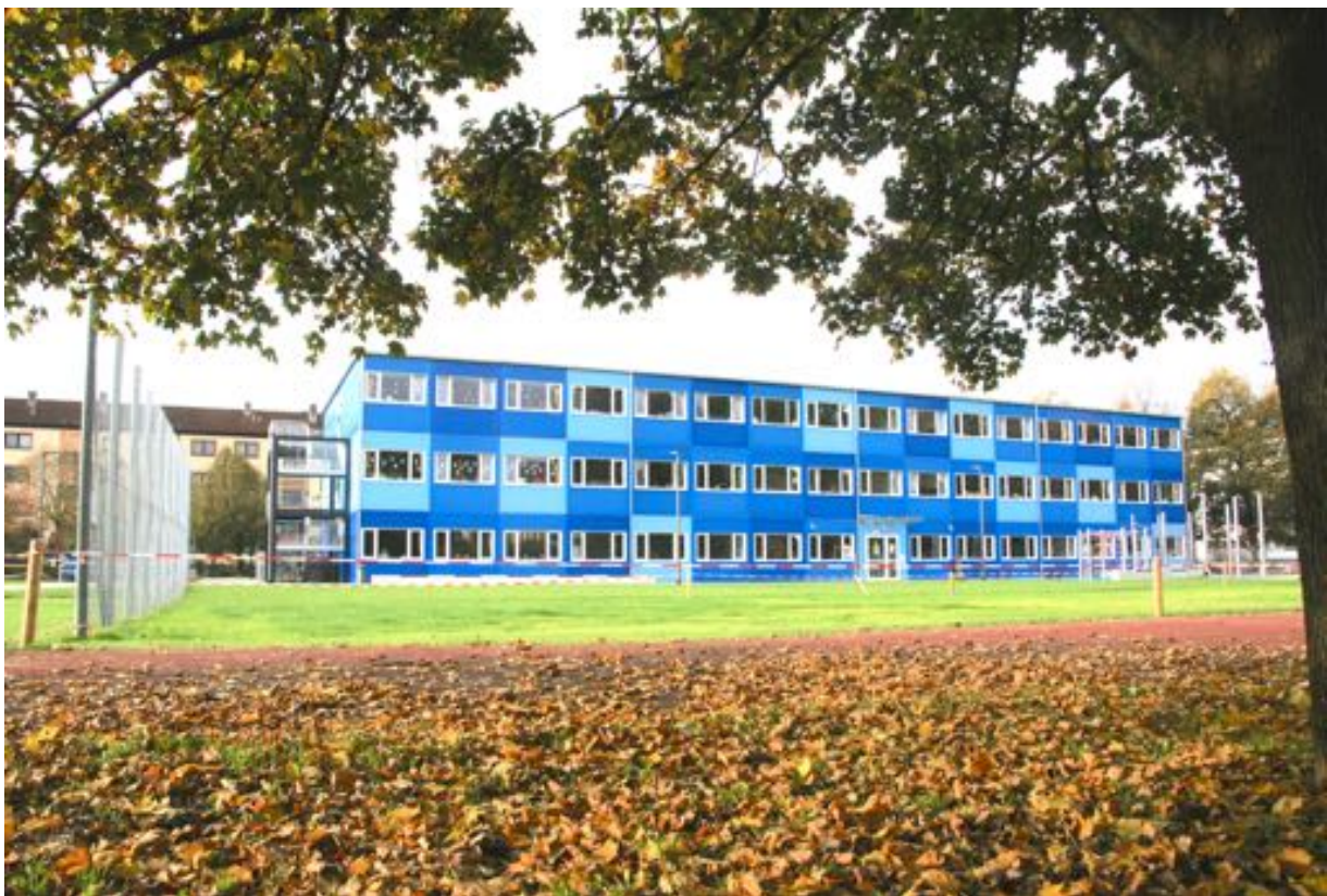
Unser „Blaues Schulhaus“ an der Josefsburgstraße, errichtet 2014 - Blick vom Sportplatz
